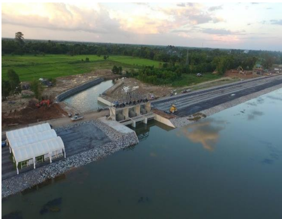
อาคารระบายน้ำล้น
