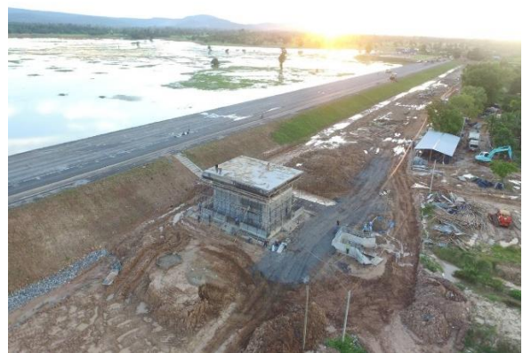
อาคารท่อน้ำฝั่งซ้าย
